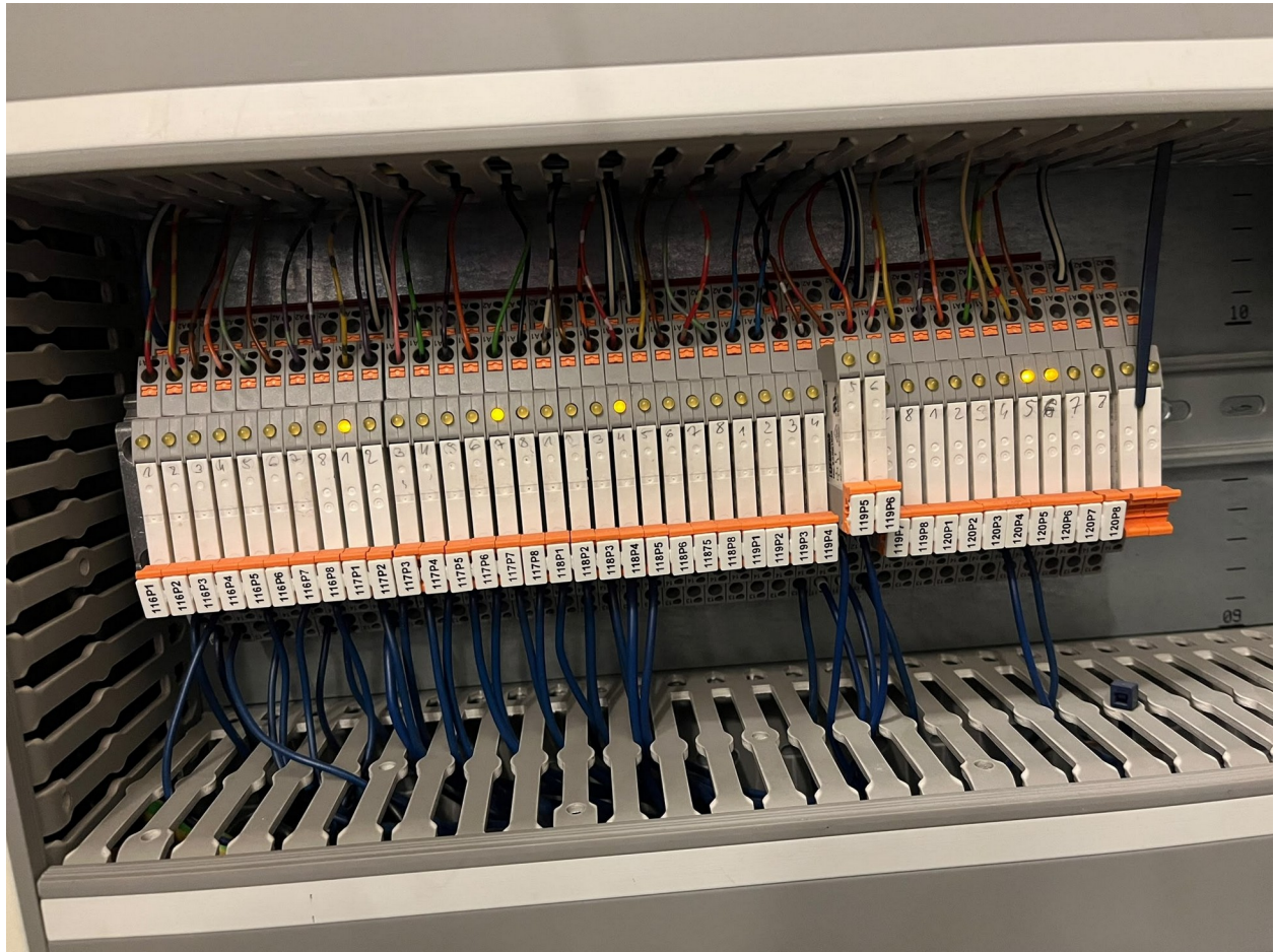
Przełączniki/interfejsy z zaciskami sprężynowymi i opisanymi przewodami.
