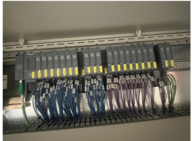
System Siemens ET 200SP z modułami I/O i wtykowymi zaciskami.
