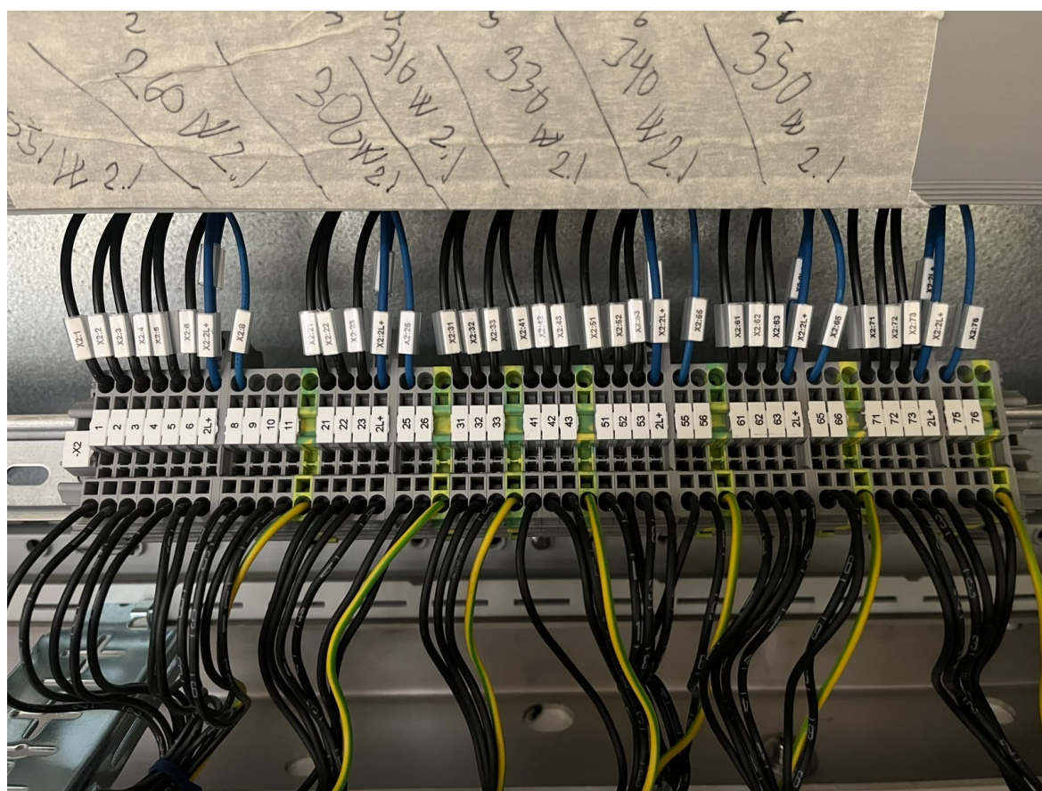
Czytelne oznaczenia zacisków i żył ułatwiają uruchomienie, diagnostykę i serwis.
